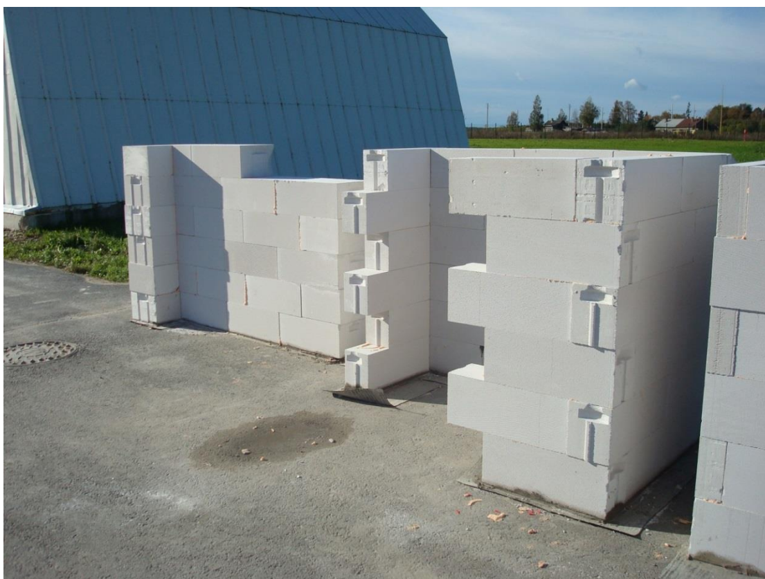
Рисунок 3. Фрагменты кладки из блоков толщиной 375 и 200 мм
