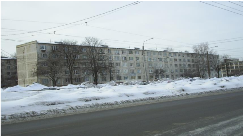
Рисунок 1. Панельное здание серии ОД-4
