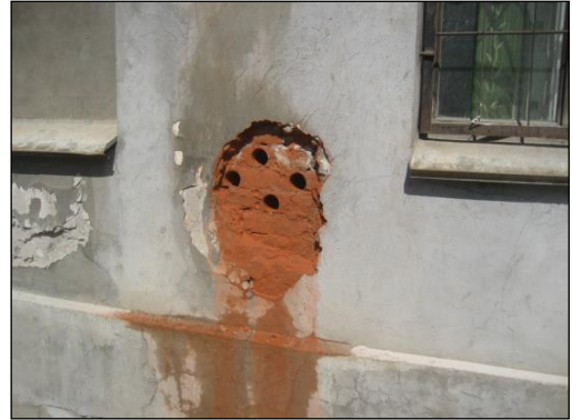
Рисунок 5. Участки отбора проб из стен здания по адресу: ул. Жукова, д.17
