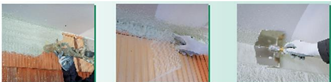
Рисунок 8. Нанесение воздухоизоляционного состава МОНО*ЭР [21]
