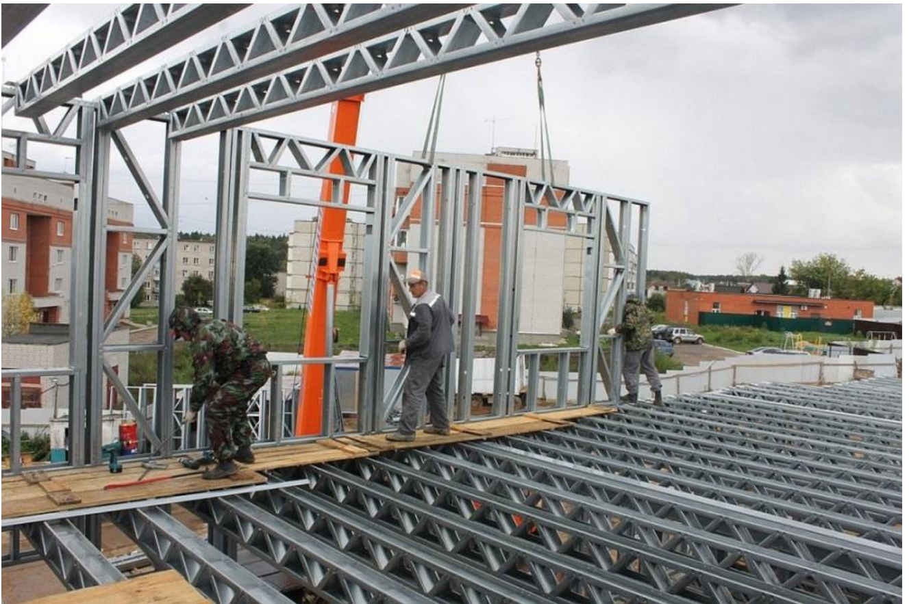
Рисунок 7. Монтаж каркаса стены [47]
