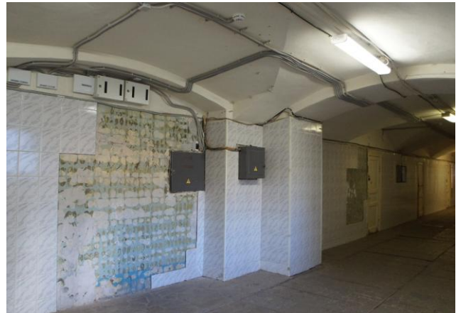
Рисунок 13. Цилиндрический свод и подпружные арки цокольного этажа
