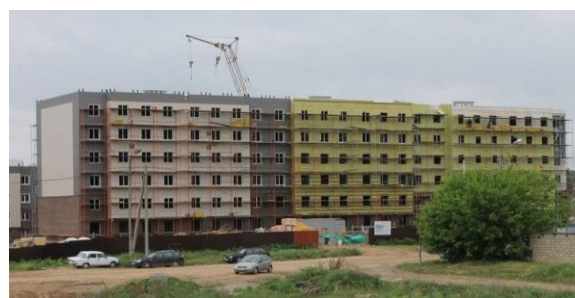
Рисунок 2. Утепление и облицовка жилого дома [27]
