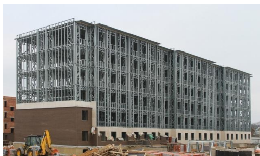
Рисунок 1. Строящийся объект СТИЛТАУН® [26]
