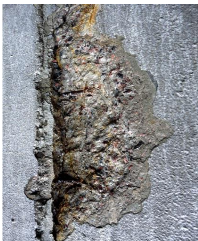
Рисунок 1. Коррозия бетона
