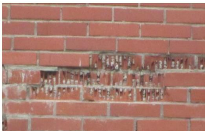
Рисунок 2. Разрушение лицевого слоя кирпичной кладки наружных стен [2]: а — на торцевых участках плит перекрытий; б — на участке примыкания к плите перекрытия
