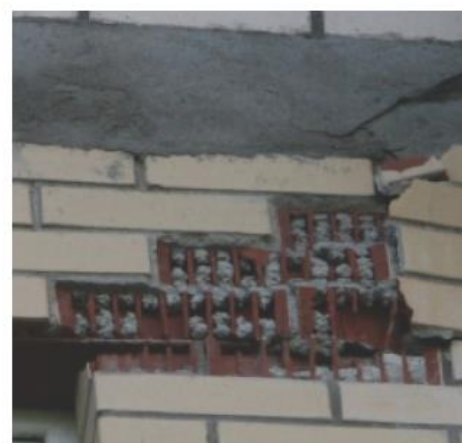
Рисунок 2. Разрушение лицевого слоя кирпичной кладки наружных стен [2]: а — на торцевых участках плит перекрытий; б — на участке примыкания к плите перекрытия
