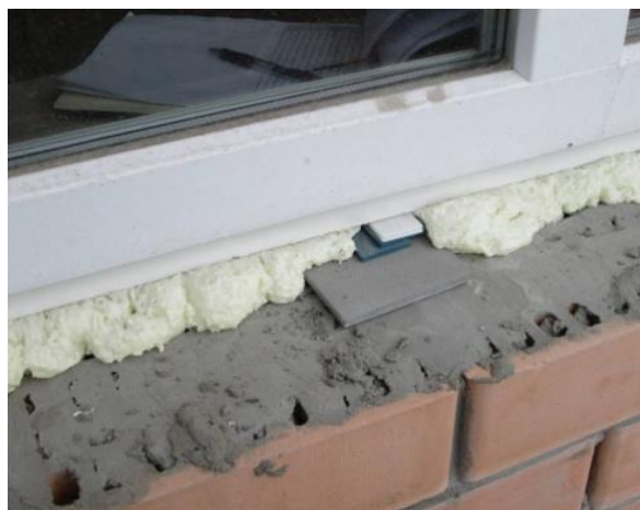
Рисунок 1. Заполнение пустот лицевого кирпичного слоя наружной стены цементно-песчаным раствором на участках примыкания оконного блока к стеновому проему: а — в зоне подоконника; б — в зоне перемычки
