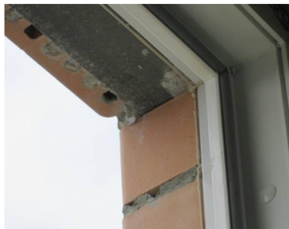
Рисунок 1. Заполнение пустот лицевого кирпичного слоя наружной стены цементно-песчаным раствором на участках примыкания оконного блока к стеновому проему: а — в зоне подоконника; б — в зоне перемычки
