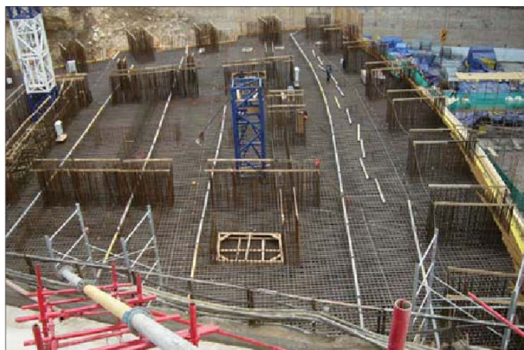
Рисунок 7. Общий вид ростверка башни «А» комплекса «Федерация». Армирование
