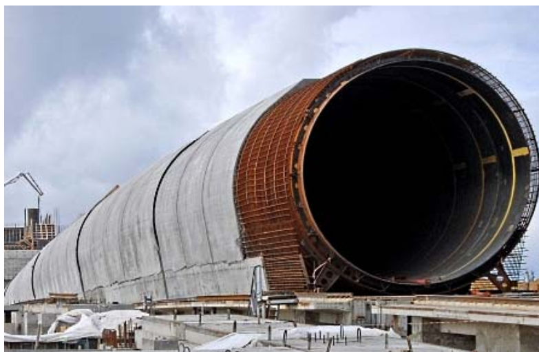
Рис. 8. Водовод Загорской ГАЭС-2
