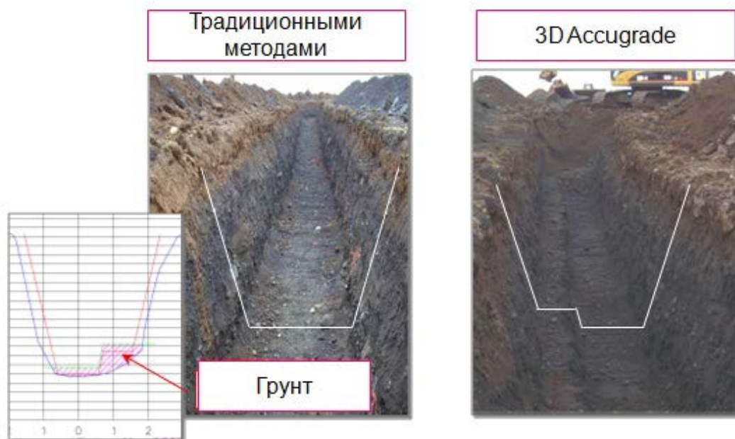
Рис. 1. Устройство траншеи для прокладки канализации
