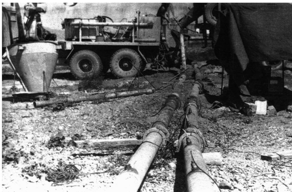
**Рис. 3. Экспериментальный участок с петлевой раскладкой бетоновода**
