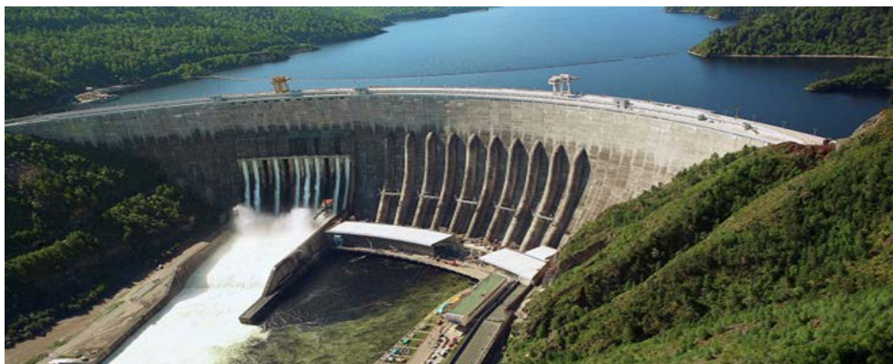
Рисунок 1. Общий вид плотины Саяно-Шушенской ГЭС
