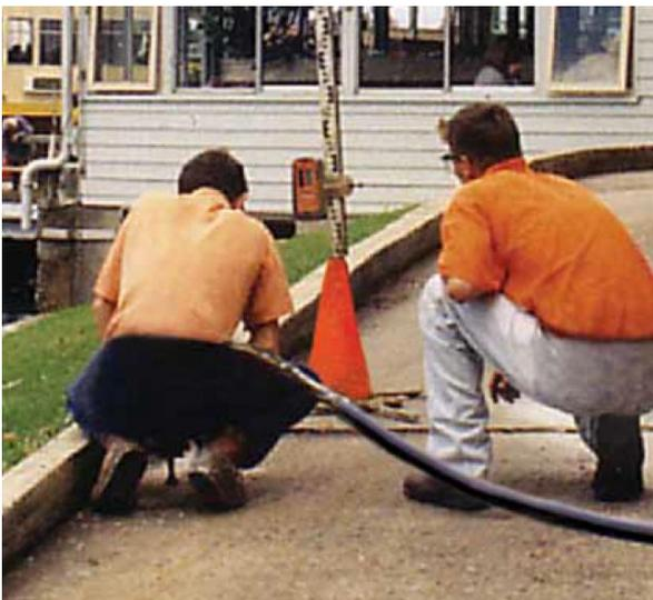
Рисунок 17. Контроль начала подъема поверхности
