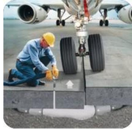
Рисунок 5. Подъем плиты при аварийном провале стойки шасси
