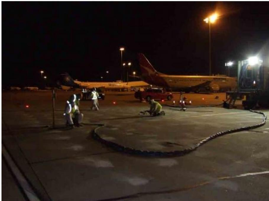
Рисунок 6. Процесс восстановления уровня бетонных плит в ночное время (светлые пятна на бетонных плитах – заделанные места инъектирования)
