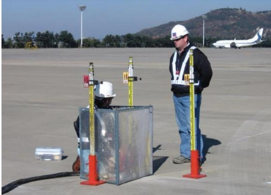
Рисунок 7. Устранение мест прогиба бетонных плит, в которых образовывались лужи и лед при отрицательных температурах. Работы выполняются на месте стоянки и не влияют на работу аэропорта
