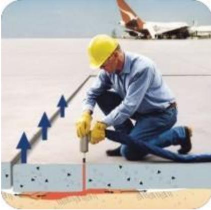
Рисунок 4. Схема подъема плиты без нагрузки
