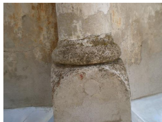
Рисунок 2. Зона образования пленки черно-зеленого налета на декоративной колонне снаружи
