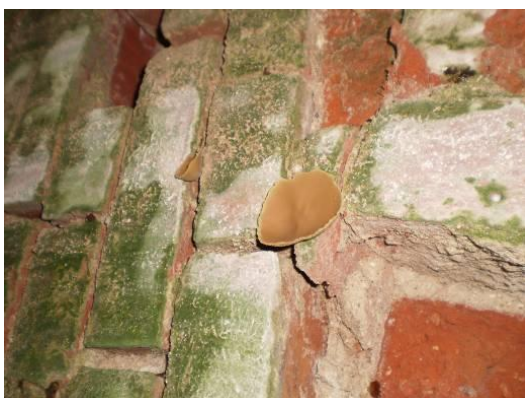
Рисунок 1. Кирпичная кладка, покрытая солевым и биологическим налетом с доминированием зеленых водорослей и образованием плодового тела гриба
