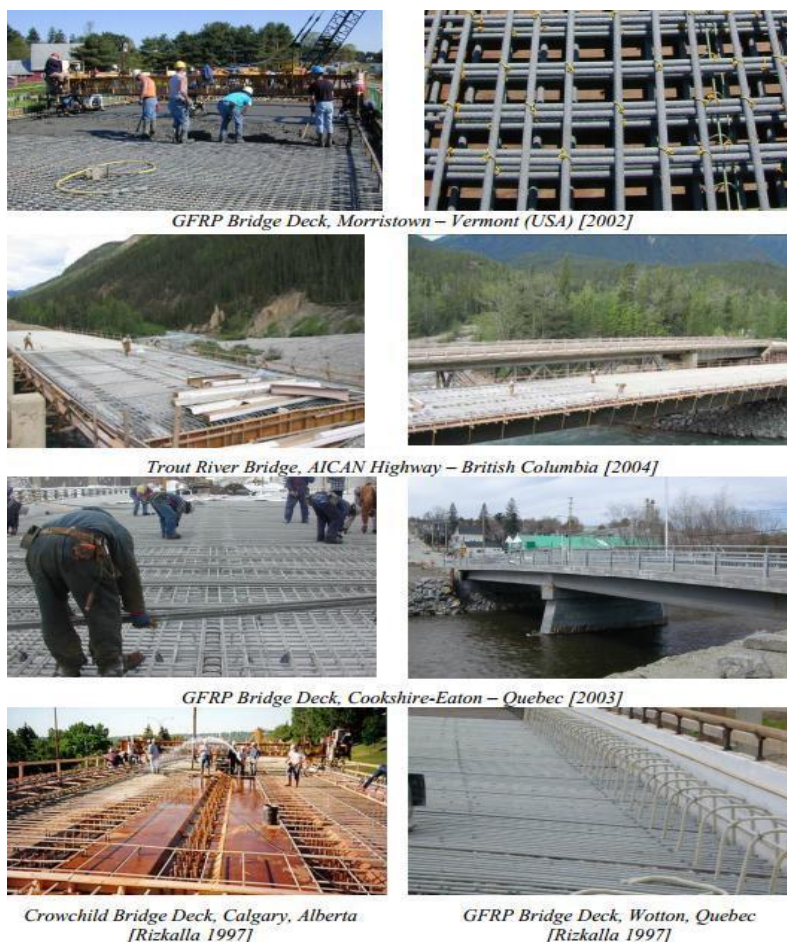
Рисунок 7. Примеры использования стеклопластика при строительстве мостов в других странах
