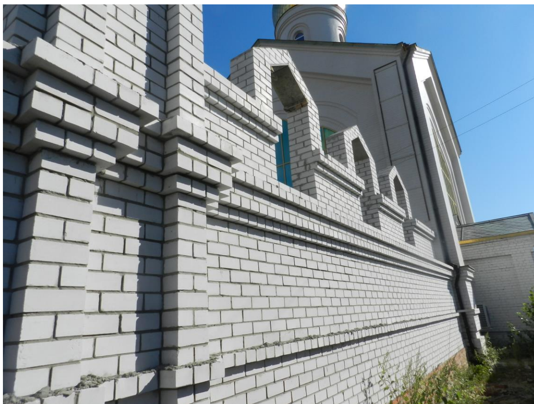
Рисунок 2. Фрагмент наружной стены пристройки к храму
