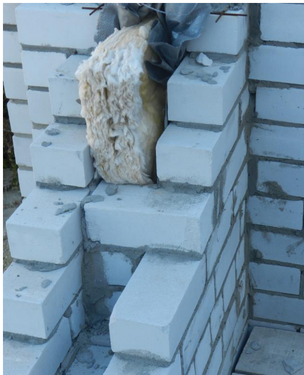
Рисунок 4. Фрагмент наружной стены в зоне вертикального ребра и горизонтального прокладного ряда кирпичной кладки
