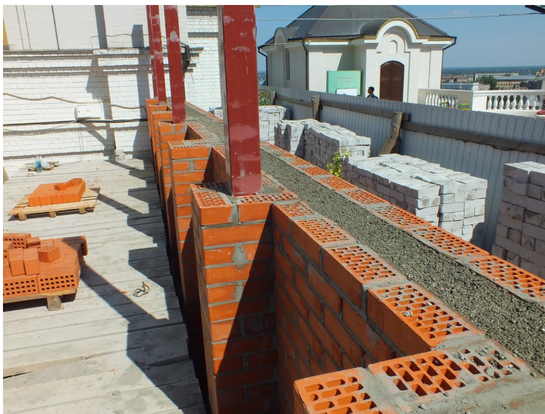
Рисунок 6. Фрагмент наружной стены с утеплением монолитным полистиролбетоном (июль 2013 года)
