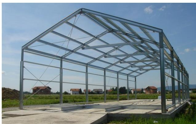
Рисунок 1. Каркас производственного здания из ЛСТК
