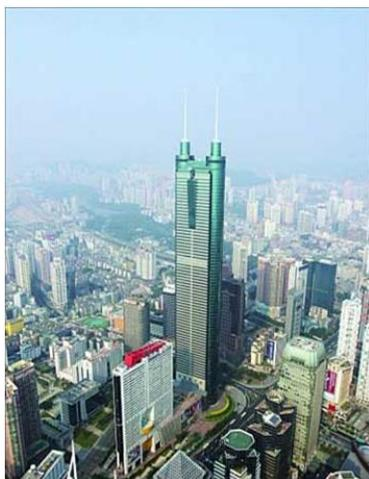
**Рисунок 1. Здание с каркасом из трубобетона на площади Сайгэ в Шэньчжэне, КНР**
