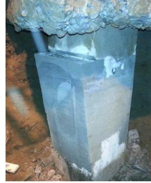
Рисунок 16. Восстановленное сечение сваи в осях 19/Д
