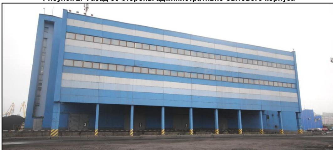
Рисунок 3. Фасад по оси А. Колонная галерея для рельсового пути
