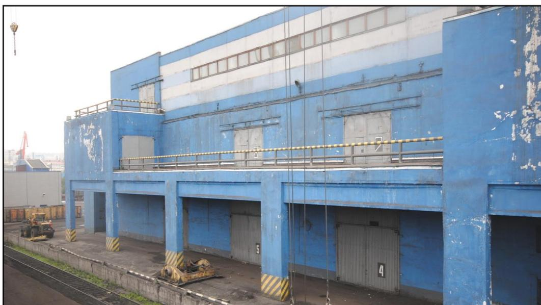
Рисунок 4. Фасад по оси П. Эстакада для погрузочной зоны. Балкон для приема грузов с крана
