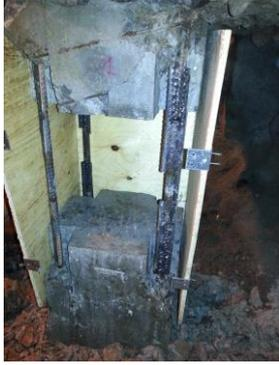
Рисунок 15. Свая в осях 19/Д с восстановленной арматурой и установленной опалубкой
