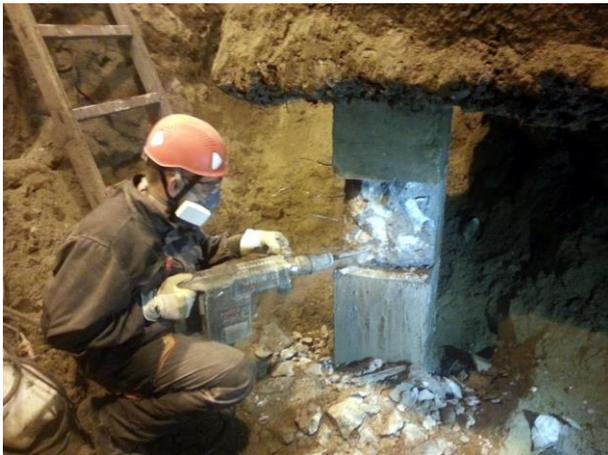
Рисунок 12. Демонтаж участка сваи в осях 19/Д
