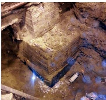
Рисунок 10. Шурф у ростверка в осях 19/Д
