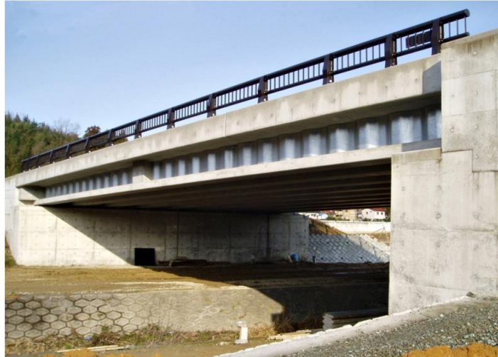
Рисунок 5. Автомобильный мост в Японии. В качестве пролетного строения моста применены балки с трапециевидно-гофрированной металлической стенкой и железобетонными поясами. [6]
