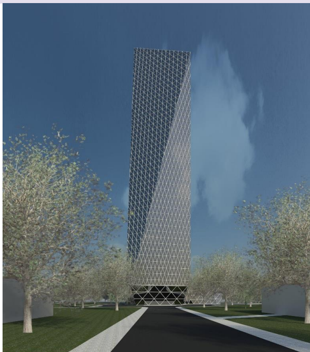
Рисунок 3. Бардин А.В. Диагонально-сетчатая несущая оболочка на примере высотного комплекса
