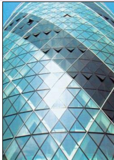
Рисунок 8. Журнал АВОК [6]. Наружное остекление здания. Видны треугольные окна световых шахт с механическими приводами, предусмотренные для использования в системе вентиляции
