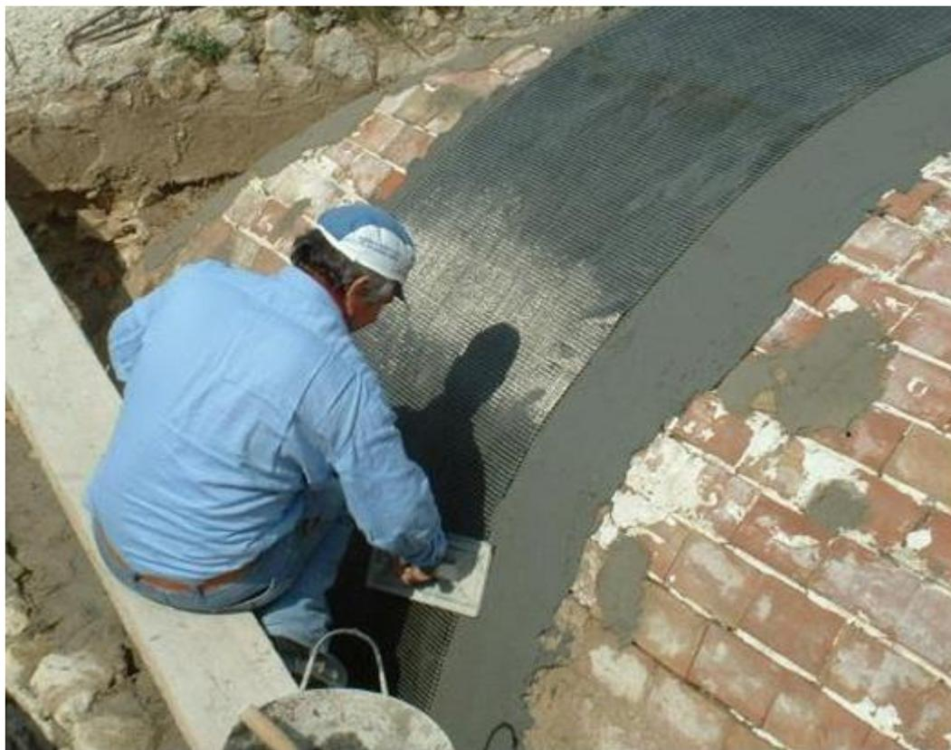
Рисунок 3. Укладка сетки из углеволокон на усиливаемый каменный свод
