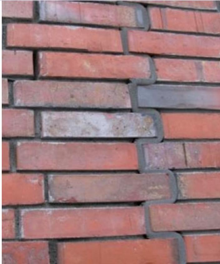
Рисунок 1. Пример устройства деформационного шва по штрабе
