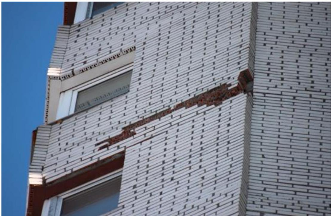
Рисунок 2. Пример деградации лицевого слоя, выполненного из высокопустотных камней с пониженной морозостойкостью
