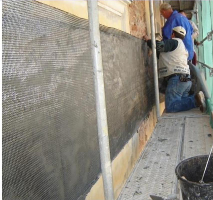
Рисунок 4. Пример усиления каменных стен армированной штукатуркой
