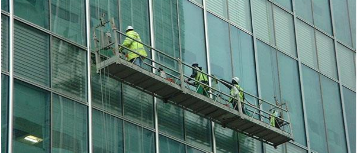
Рисунок 3: Выполнение работ с подвесной фасадной конструкцией [40].
