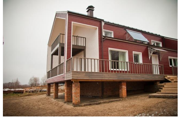
Рисунок 2. Дом с ультранизким потреблением энергии (Нижегородская обл.) [35]
