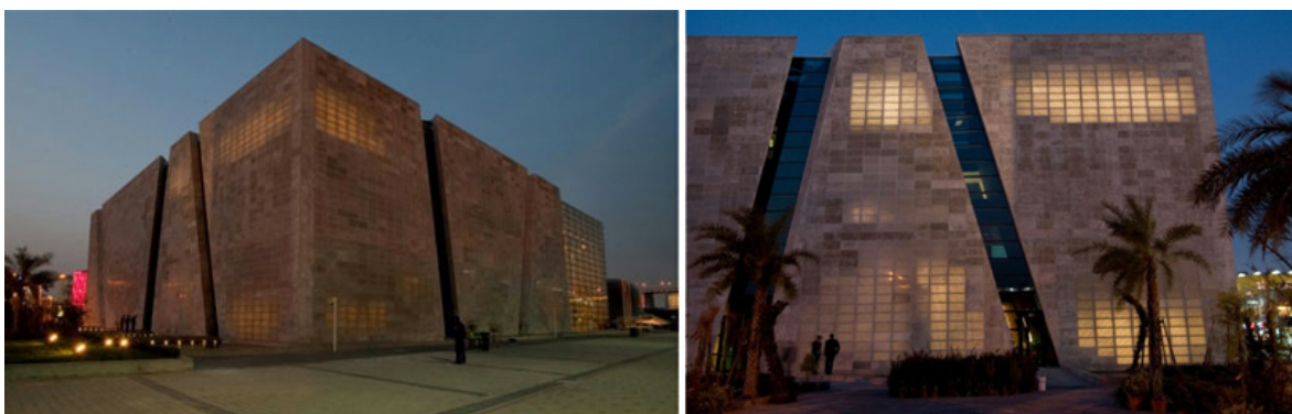
Рисунок 2. Здания из прозрачного бетона [10]
