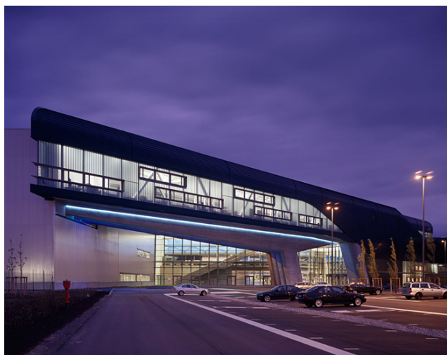
Рисунок 4. Здание автомобильного завода BMW в Лейпциге [15]
