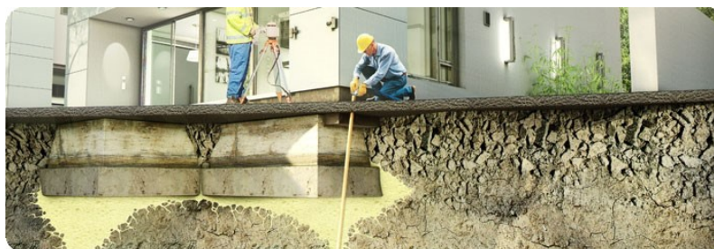
Рисунок 1. Применение технологии SLAB LIFTING [35]
