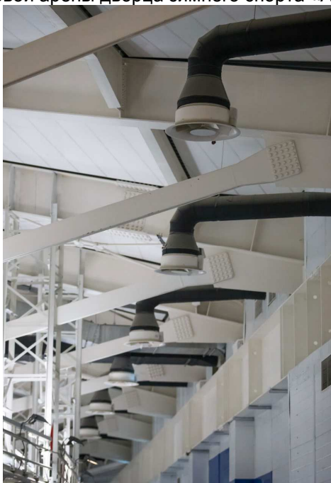
Рисунок 18. Подача приточного воздуха в верхнюю зону трибун дворца зимнего спорта «Айсберг» (г. Сочи, Россия) [50]
