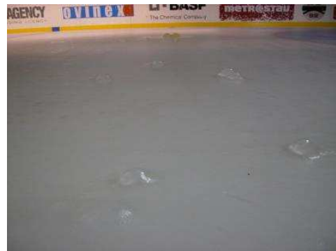
Рисунок 1. Конденсация влаги на строительных конструкциях [32] а) конденсат на поверхности покрытия; б) «капель» на поверхности льда
