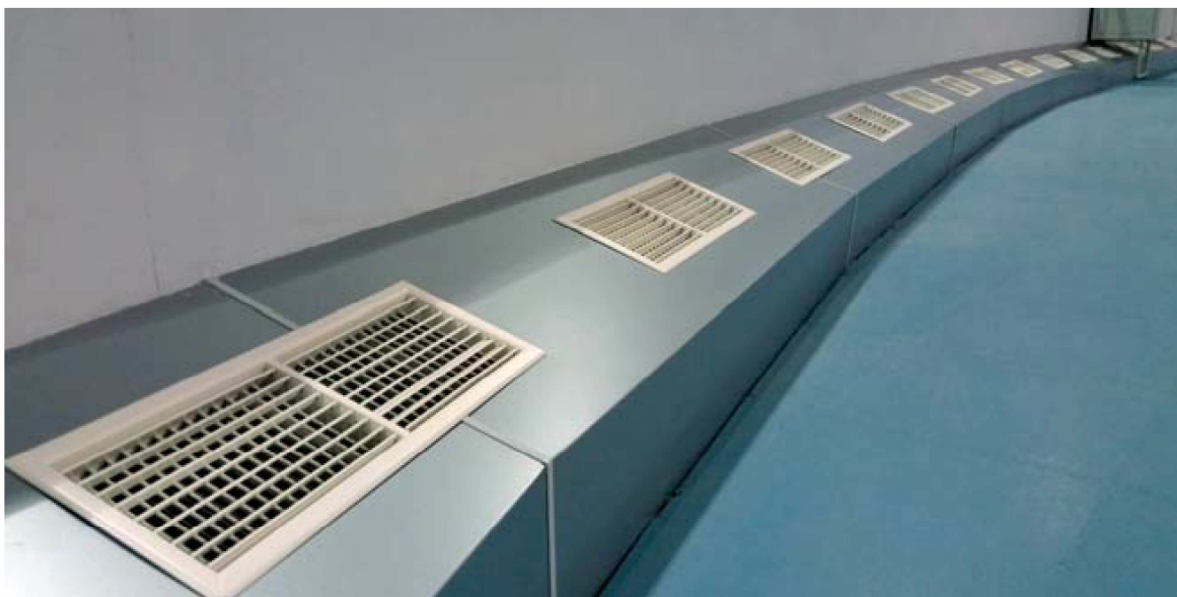
Рисунок 13. Подача приточного воздуха в нижнюю зону для зрителей на трибунах [30]
