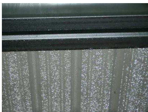
Рисунок 1. Конденсация влаги на строительных конструкциях [32] а) конденсат на поверхности покрытия; б) «капель» на поверхности льда
