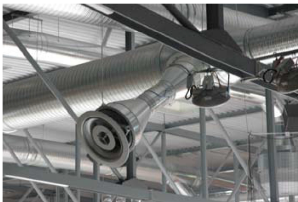
Рисунок 21. Регулируемый диффузор [51]
