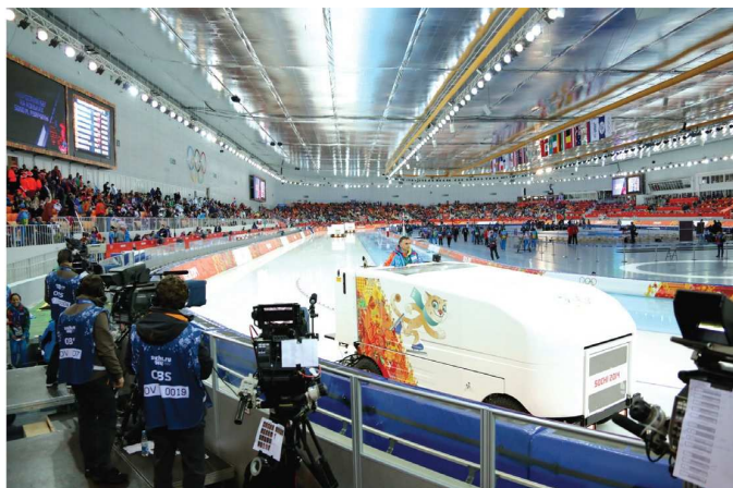
Рисунок 3. Пример применения отражающего экрана в «Адлер-Арене» (г. Сочи, Россия) [30]
