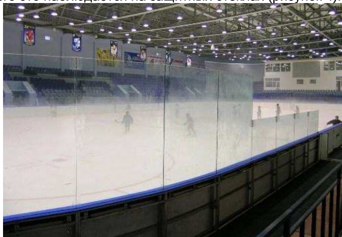
Рисунок 4. Конденсация влаги на защитных стеклах хоккейных бортов [34]
