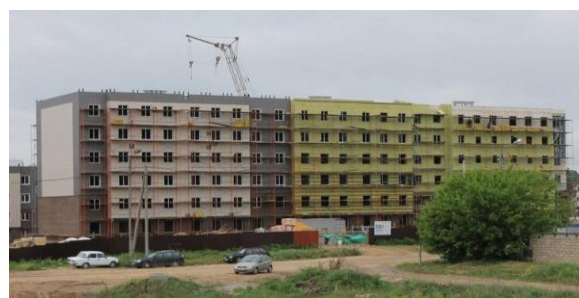
Рисунок 2. Утепление и облицовка жилого дома [27]
