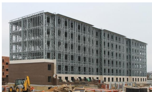
Рисунок 1. Строящийся объект СТИЛТАУН® [26]
