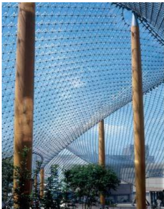
Рисунок 1. Остекленный тросовый сетчатый фасад свободной формы: Rhön Klinikum, Бад-Нойштадт, Германия
