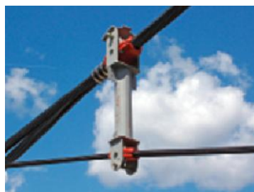
Рисунок 3. Трубчатая стойка между несущими и стабилизирующими вантами
