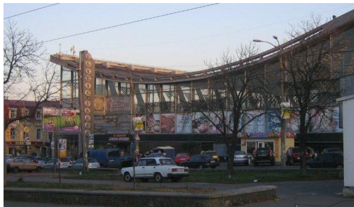
Рисунок 24. Крытый рынок в Киеве по ул. Верхний Вал с одноярусным цилиндрическим висячим тросовым покрытием
