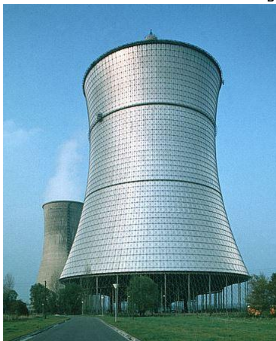
Рисунок 31. Тросовая башня градирни с центральным пилоном (Германия)
