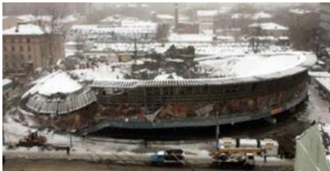
Рисунок 18. Обрушение Басманного рынка 23.02.2006 г., Москва
