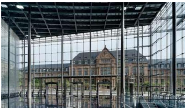
Рисунок 4. Остекленная тросовая фасадная структура: новый международный аэропорт Suvarnabhumi в Бангкоке, Таиланд (проектирование фасада: Werner Sobek Ingenieure)
