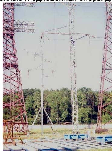
з) Мобильная промежуточная опора 220кВ для Украины
