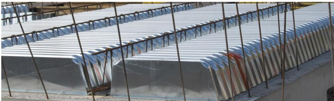
Рисунок 7 Тонкостенные вкладыши перекрытия «МАРКО-ПРОСТОР» [1]
