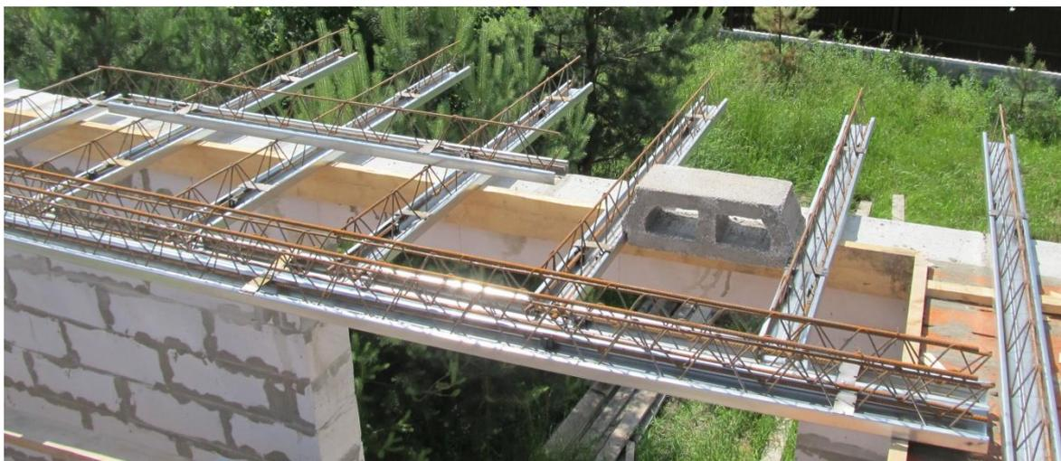
Рисунок 4 Устройство балкона с использованием перекрытий «МАРКО-ПРОФИЛЬ» [1]
