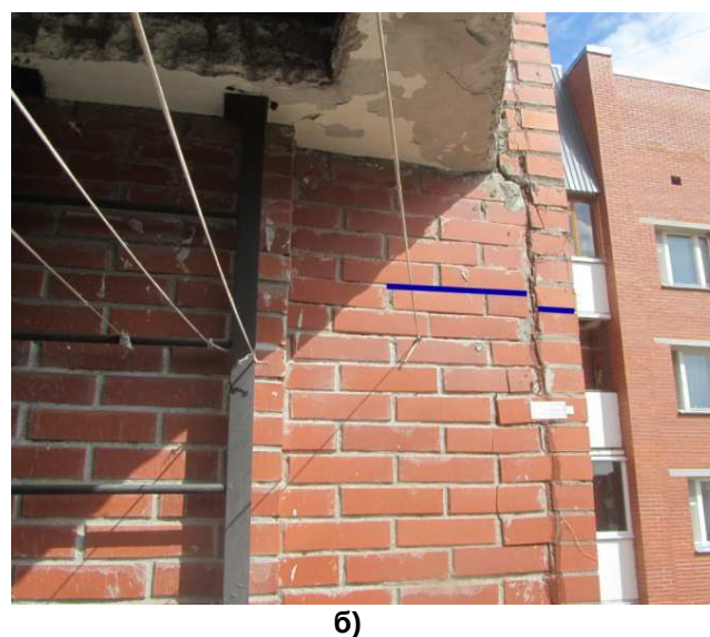
Рисунок 6. Деформации кладки: а) продольные деформации, б) срез кладки
