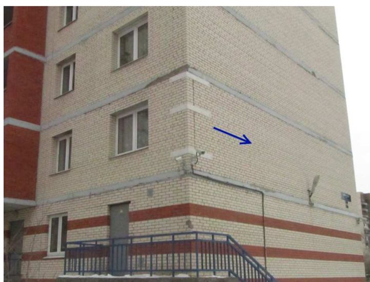
Рисунок 4. Вертикальная трещина, вызванная деформациями, направленными от угловой зоны торцевой стены
