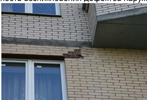
Рисунок 9. Наложение механизмов образования деструкции кладки
