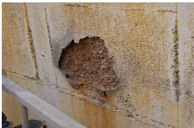
**Рис. 3. После деградации защитного покрытия бетон подвергнулся воздействию подкисленного конденсата дымовых газов.**
