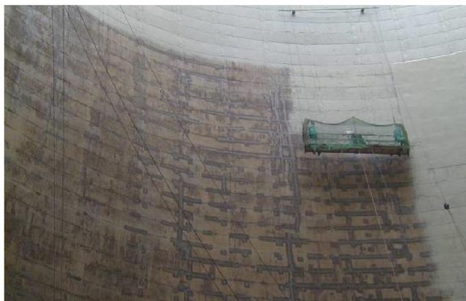
**Рисунок 12. Отдельные участки повреждения и восстановление профиля с использованием полимерцементного бетона.**
