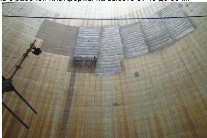
Рисунок 11. Нанесение торкретируемого полимерцементного бетона (SPCC)
