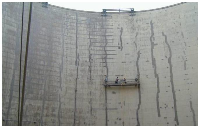
Рисунок 10. Глубокие трещины, на которые наносится специальное покрытие
