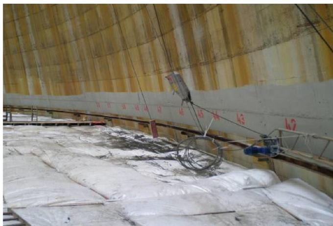
**Рисунок 8. Круговая направляющая и опорная тележка с механизмом предварительного натяжения.**
