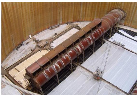
Рисунок 2. Защитная сетка и настил
