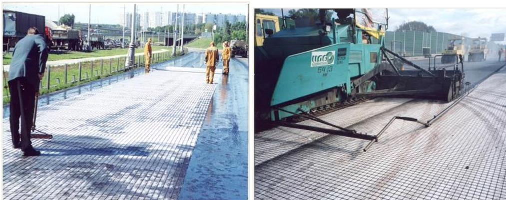
**Рис. 1. Применение георешетки с подложкой из геотекстиля при строительстве МКАД в качестве прослойки, армирующей асфальтовое покрытие.**
