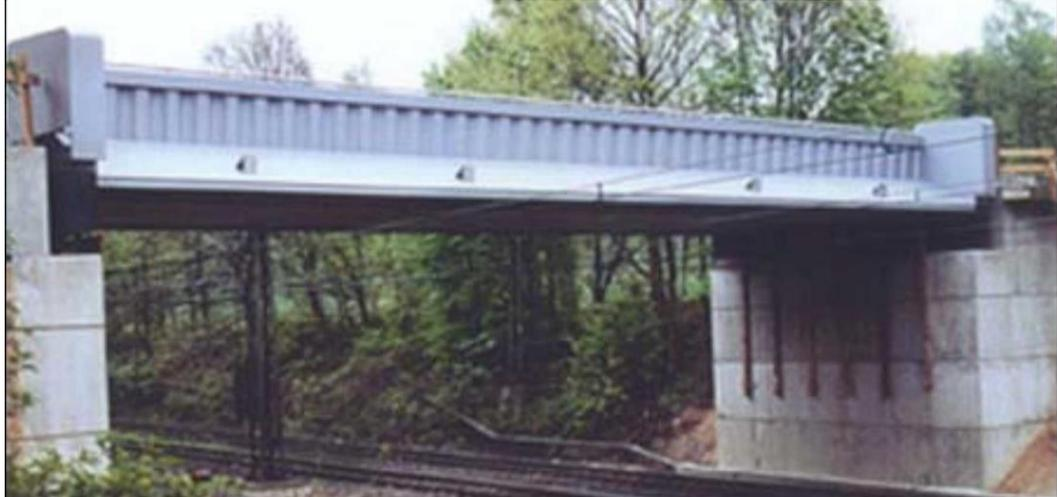
Рис. 25. Балочный мост с трапецидальным очертанием гофров [36]
