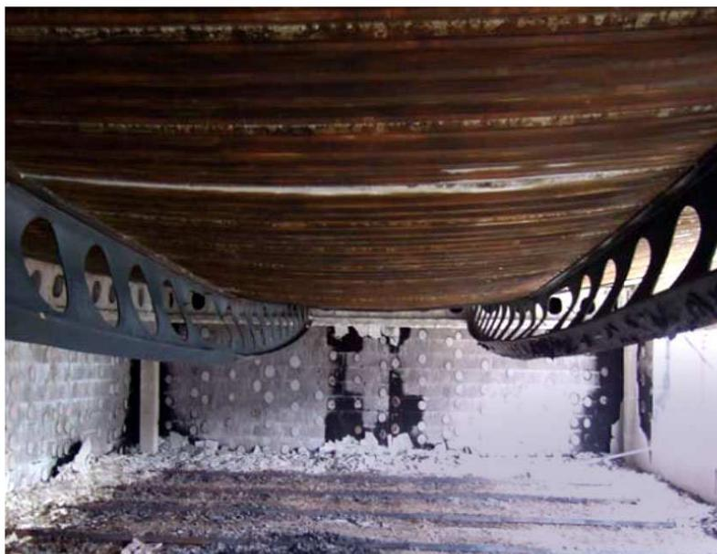
**Рисунок 2. Результаты огневого воздействия на металлические балки перекрытия [16]**
