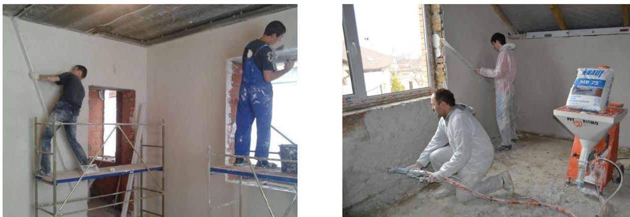
**Рисунок 1. Ручной и механизированный способы выполнения штукатурных работ**
