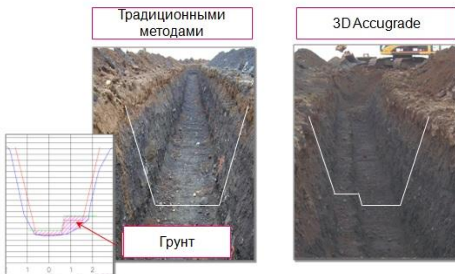
Рисунок 1. Устройство траншеи для прокладки канализации
