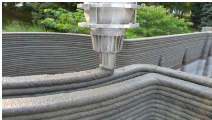
Рисунок 2. Процесс построения по технологии Concrete Printing
