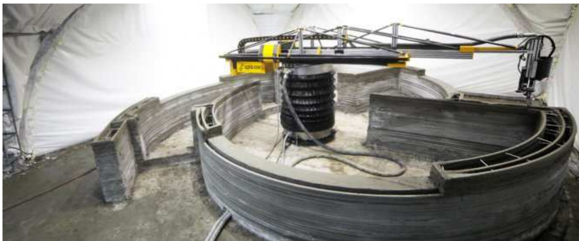
Рисунок 16. Процесс работы 3D-принтера ApisCor
