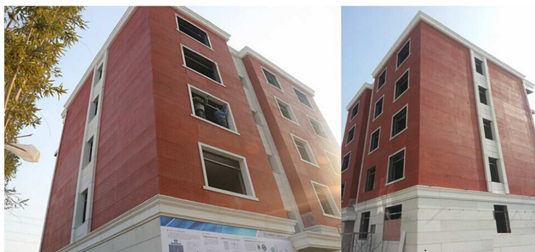
Рисунок 18. Напечатанный пятиэтажный дом в Китае
