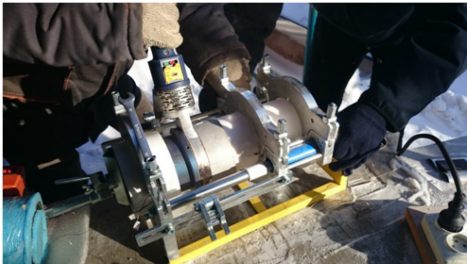
Рис. 4. Нагревание (оплавление) внутренней поверхности муфты и внешней поверхности трубы с помощью насадок для сварки
