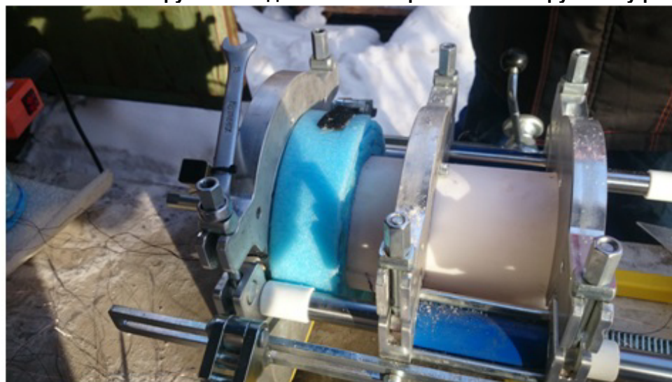
Рис. 6. Охлаждение сварного раструбного соединения под слоем теплоизоляции после сварки при низких температурах (8 минут)
