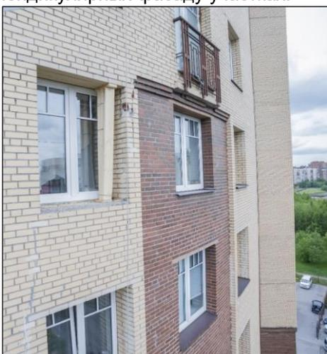
Рисунок 22. Фотография фасада с дрона. Для построения ортофотоплана фасада выполняются снимки с разных ракурсов
