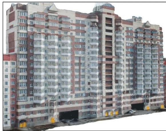
Рисунок 21. Виртуальная «плиточная» модель здания для визуального осмотра
