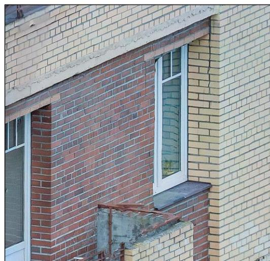
Рисунок 23. Фрагмент готового ортофотоплана фасада под углом. Видно вертикальную трещину в простенке
