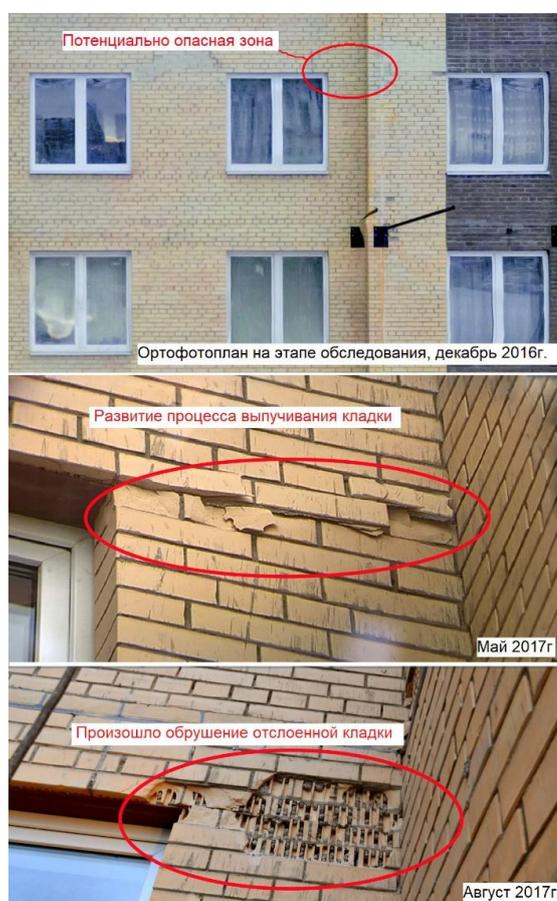
Рисунок 30. Наблюдение за проблемным участком кирпичной кладки жилого здания
