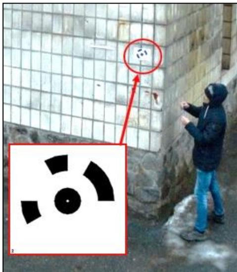
**Рисунок 11. Установка распечатанных маркеров на фасад для авто-распознавания**
