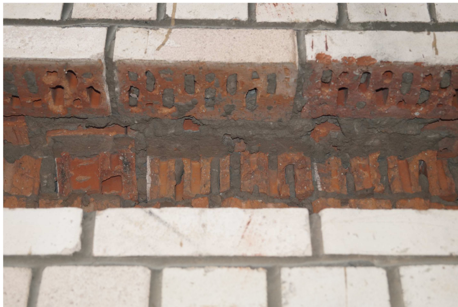
Рисунок 16. Заполнение раствором пустот в лицевых и рядовых изделиях наружных каменных стен
