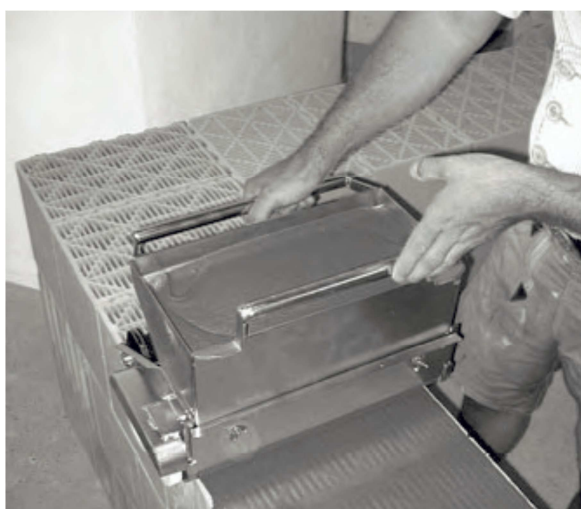
Рисунок 19. Кладка на тонкослойных кладочных составах
