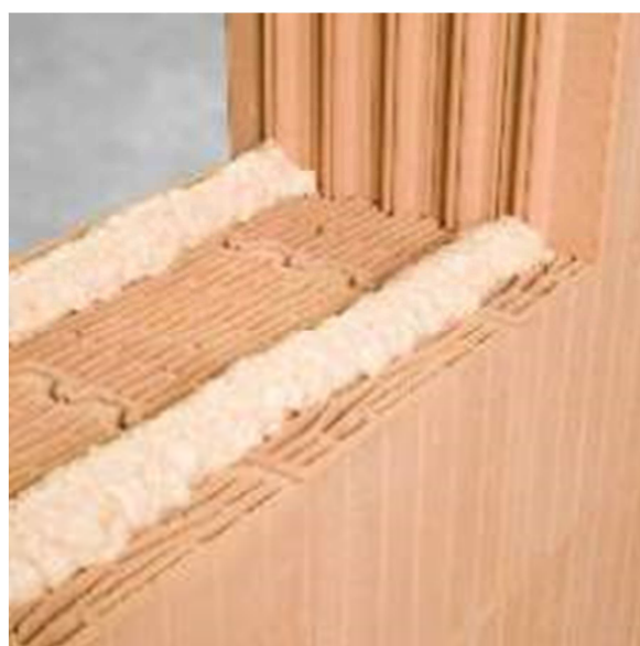
Рисунок 20. Применение полиуретанового клея для кладки наружных стен из крупноформатных керамических камней [15]
