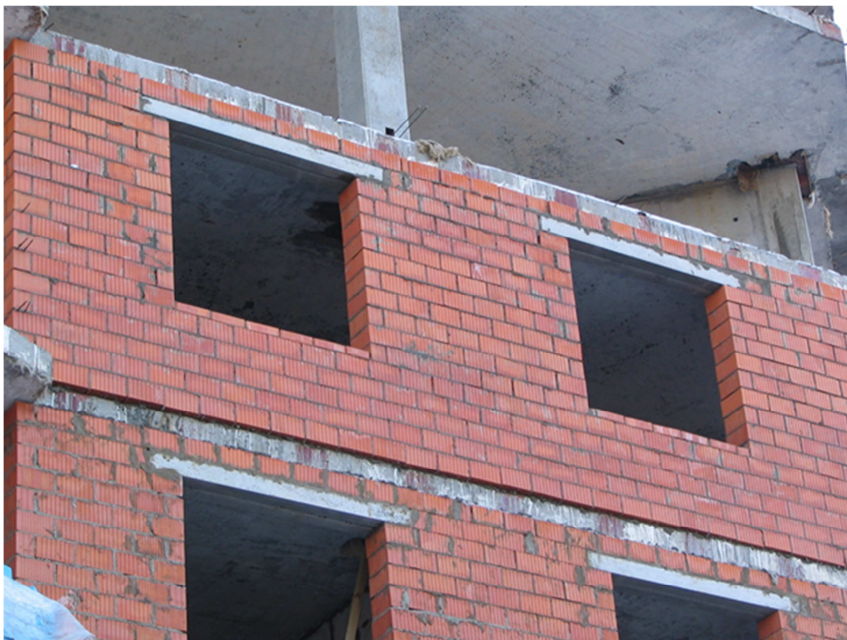
Рисунок 12. Внутренний каменный слой многослойной наружной стены
