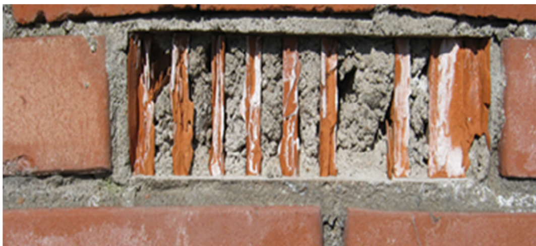
Рисунок 14. Заполнение раствором пустот в облицовочном каменном слое
