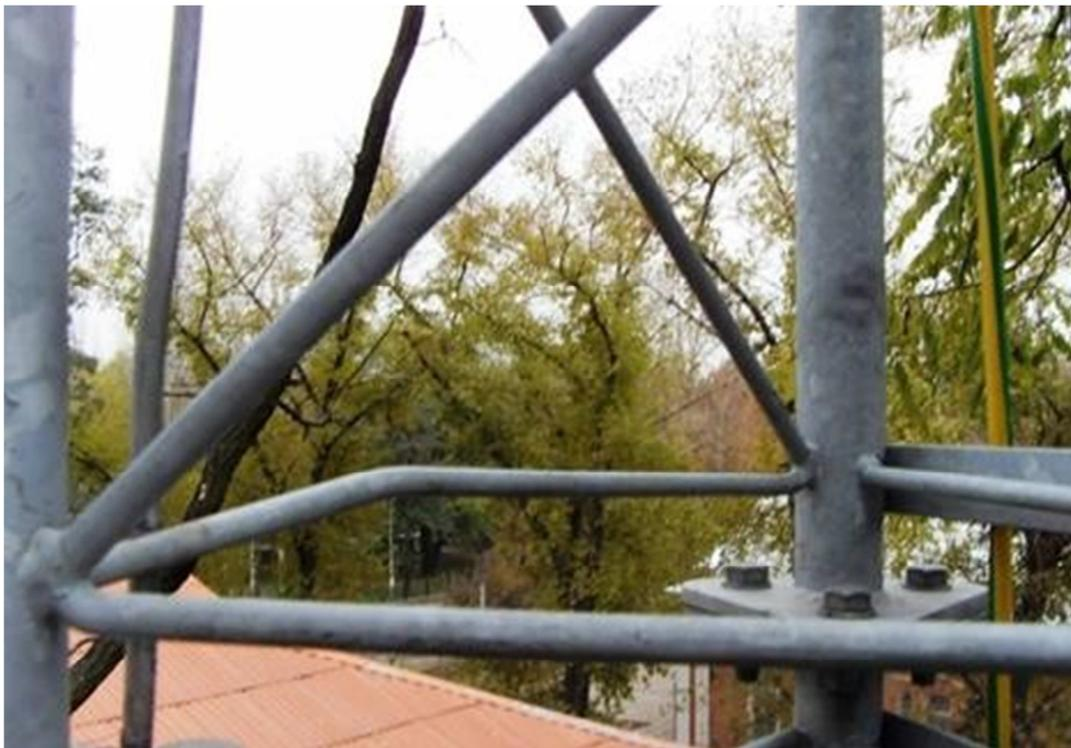
**Рисунок 7. Искривление распорки ствола**
