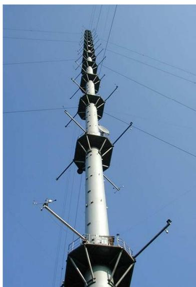
Рисунок 3. Фрагмент сплошностенчатой трубчатой мачты
