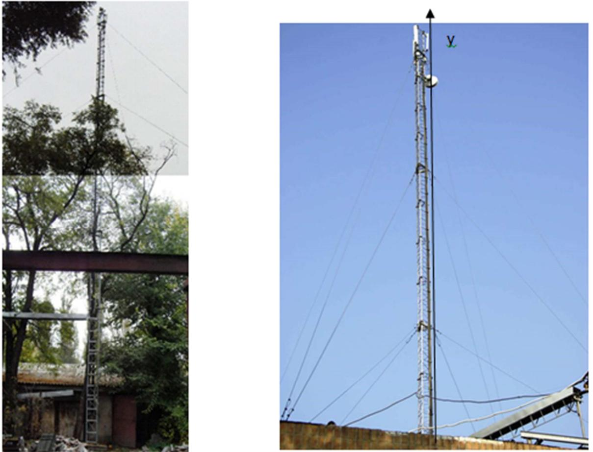
**Рис.6. Мачты на оттяжках с отклонениями оси оттяжек от вертикали.**
