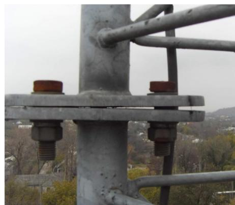
**Рисунок 11. Зазоры между соединительными фланцами**
