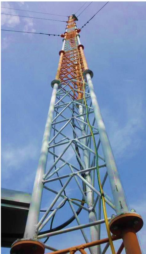
**Рисунок 8. Смещение оси элементов решетки**
