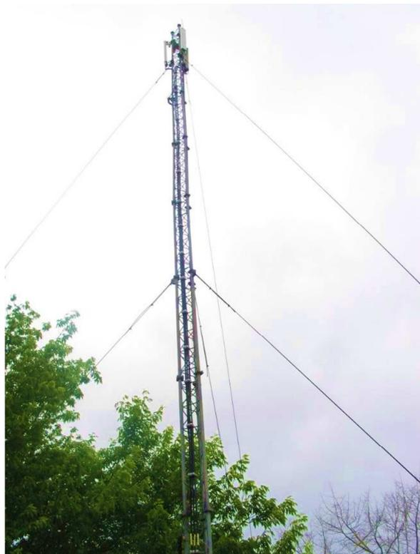
**Рисунок 9. Закручивание ствола мачты по высоте**
