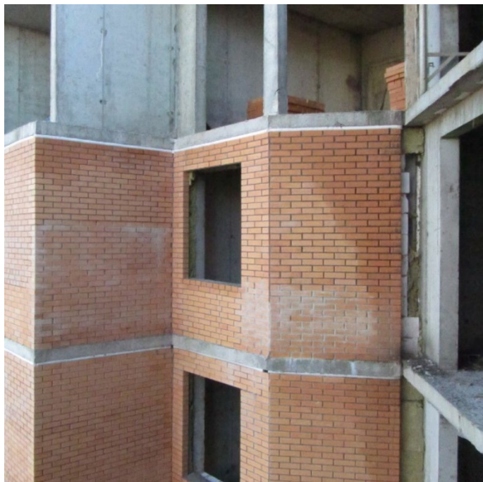
Рис. 1– Фрагмент здания возведённого по монолитной технологии (фотографии авторов) а) Фрагмент сопряжения наружной стены здания с диском перекрытия; б) Диск перекрытия с перфорацией под термовкладыши; в) Поэлементная разбивка диска перекрытия Fig. 1– Fragment of a building erected using monolithic technology (photos of the authors) а) Fragment of the conjugation of the outer wall of the building with the floor disc; б) Overlapping disc with perforation for thermal inserts; в) Element-wise partitioning of the overlap disk
