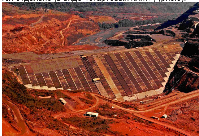
Рис.9. Плотина Foz do Areia во время строительства (вид с верхнего бьефа)
